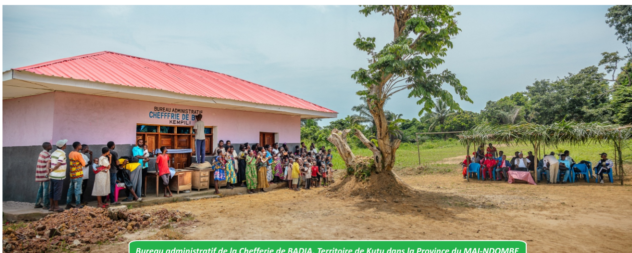
Bureau administratif de la Chefferie de BADIA, Territoire de Kutu dans la Province du MAI-NDOMBE
